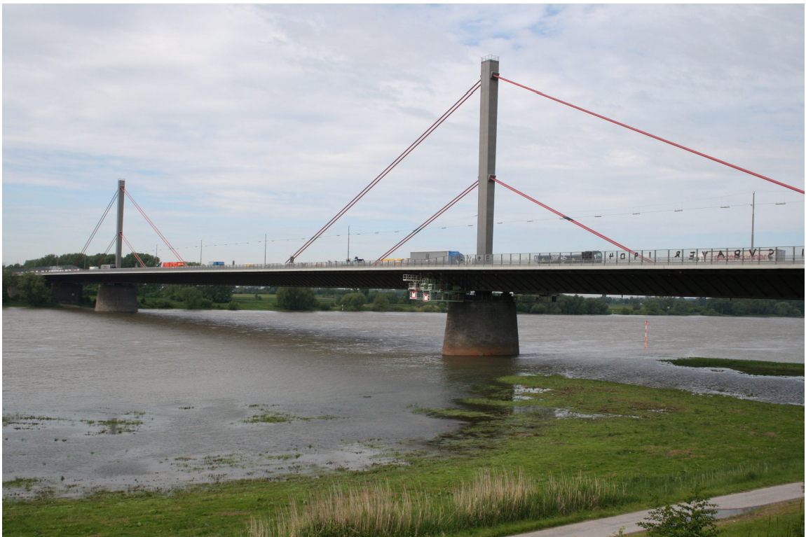
Abbildung 2: Rheinland- und Vorlandbrücke Leverkusen an der Autobahn A1 Bildquelle: Pro Mobilität
